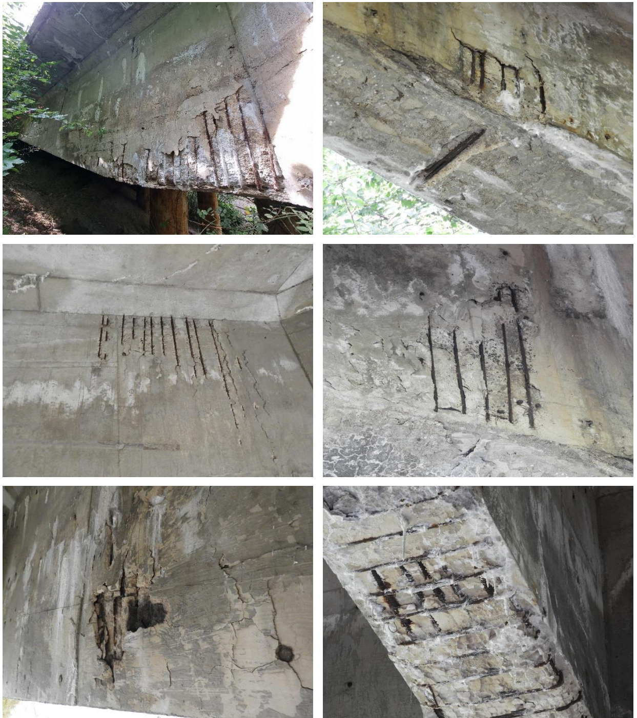
Fot. 3.33. Przykładowe fotografie przedstawiające stan techniczny konstrukcji dźwigarów głównych i poprzecznic
