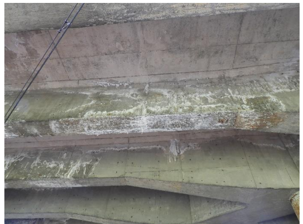
Fot. 3.30. Przykładowe fotografie przedstawiające stan techniczny konstrukcji dźwigarów głównych i poprzecznic
