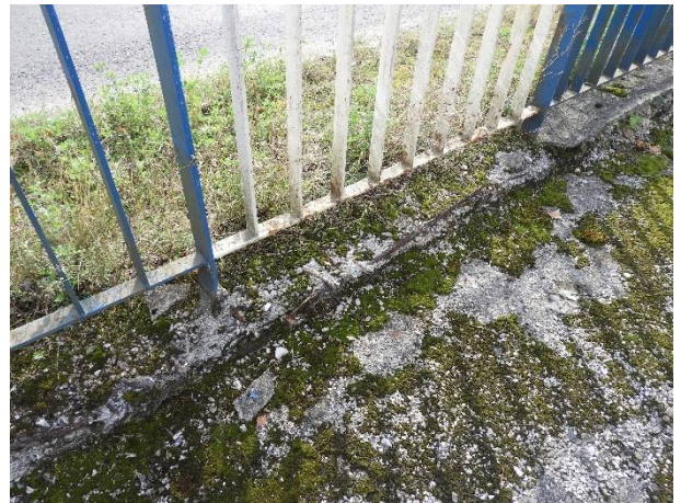
Fot. 3.17. Przykładowe fotografie przedstawiające stan techniczny belek podporęczowych, gzymsów
