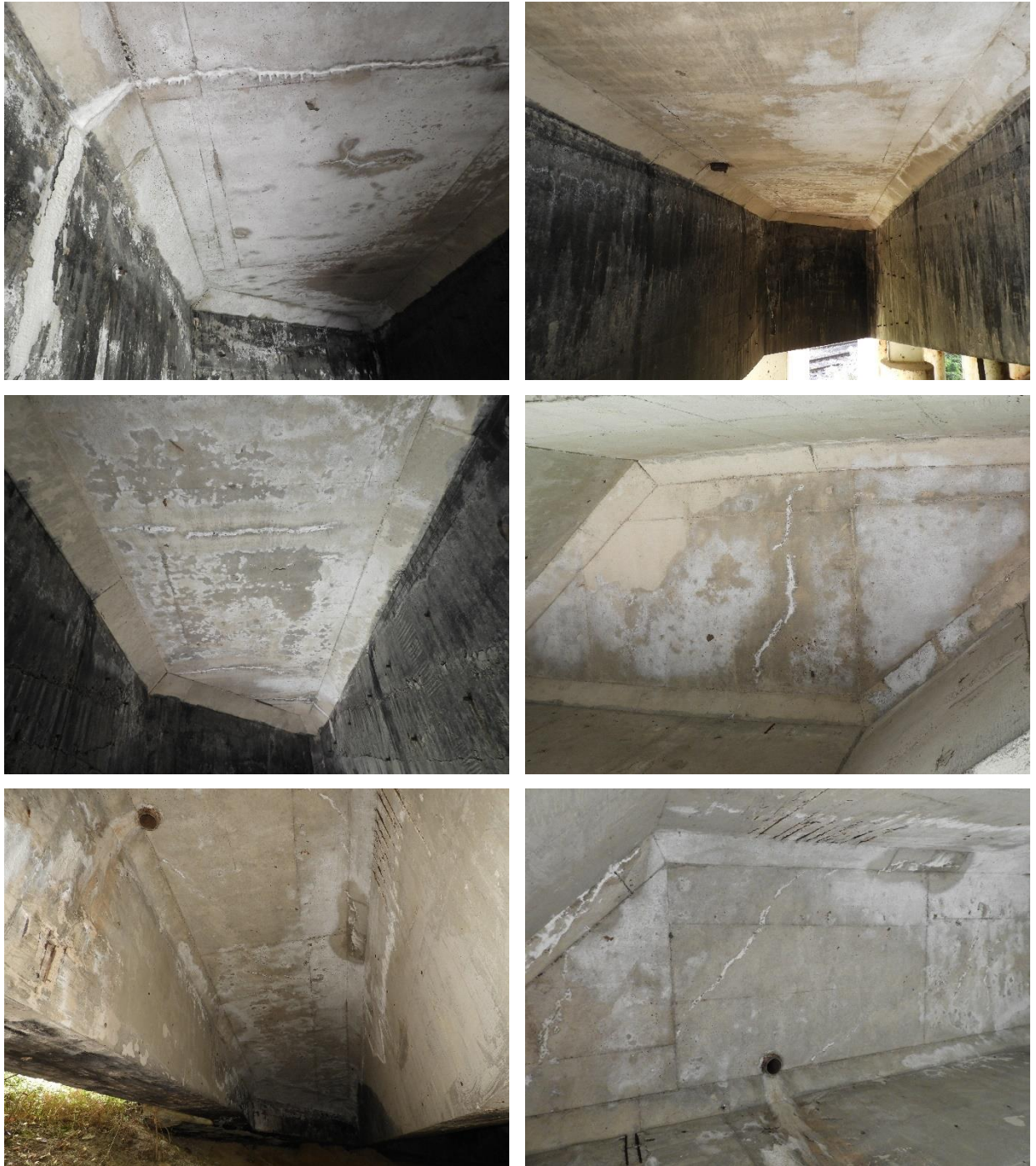
Fot. 3.26. Przykładowe fotografie przedstawiające stan techniczny konstrukcji pomostu
