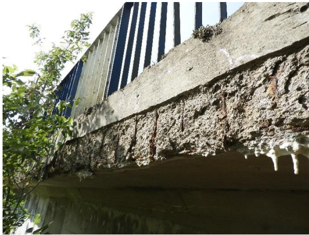
Fot. 3.19. Przykładowe fotografie przedstawiające stan techniczny belek podporęczowych, gzymsów
