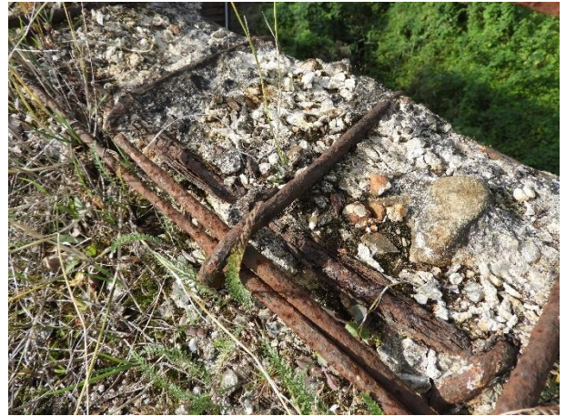
Fot. 3.20. Przykładowe fotografie przedstawiające stan techniczny belek podporęczowych, gzymsów
