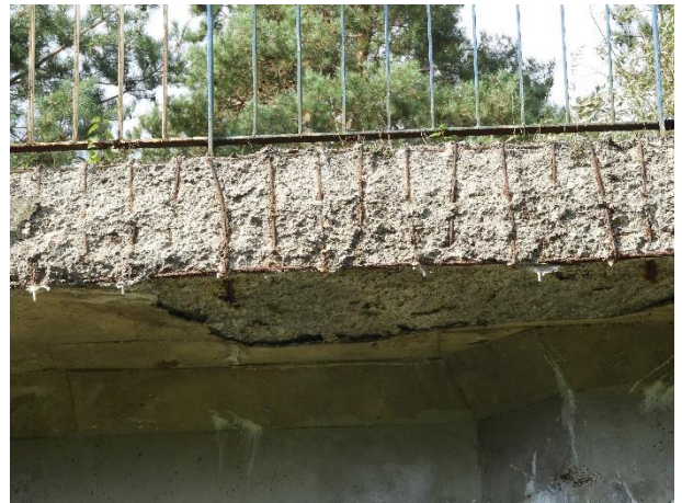
Fot. 3.18. Przykładowe fotografie przedstawiające stan techniczny belek podporęczowych, gzymsów
