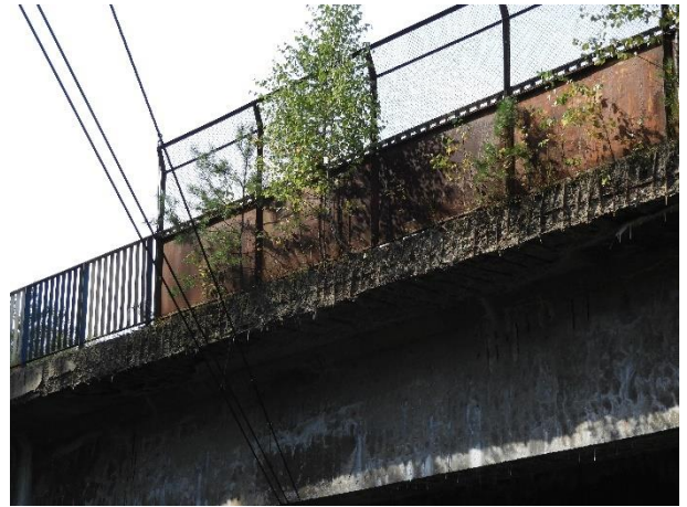
Fot. 3.17. Przykładowe fotografie przedstawiające stan techniczny belek podporęczowych, gzymsów
