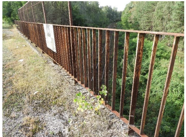
Fot. 3.13. Przykładowe fotografie przedstawiające stan techniczny balustrad, osłon przeciwporażeńowych
