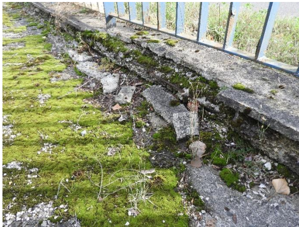
Fot. 3.17. Przykładowe fotografie przedstawiające stan techniczny belek podporęczowych, gzymsów
