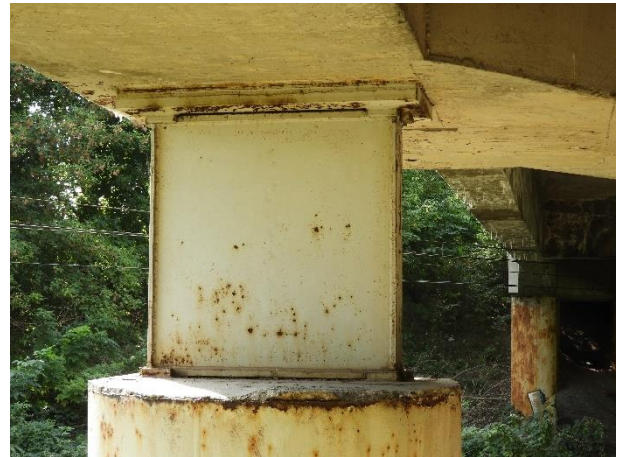
Fot. 3.35. Przykładowe fotografie przedstawiające stan techniczny przegubów
