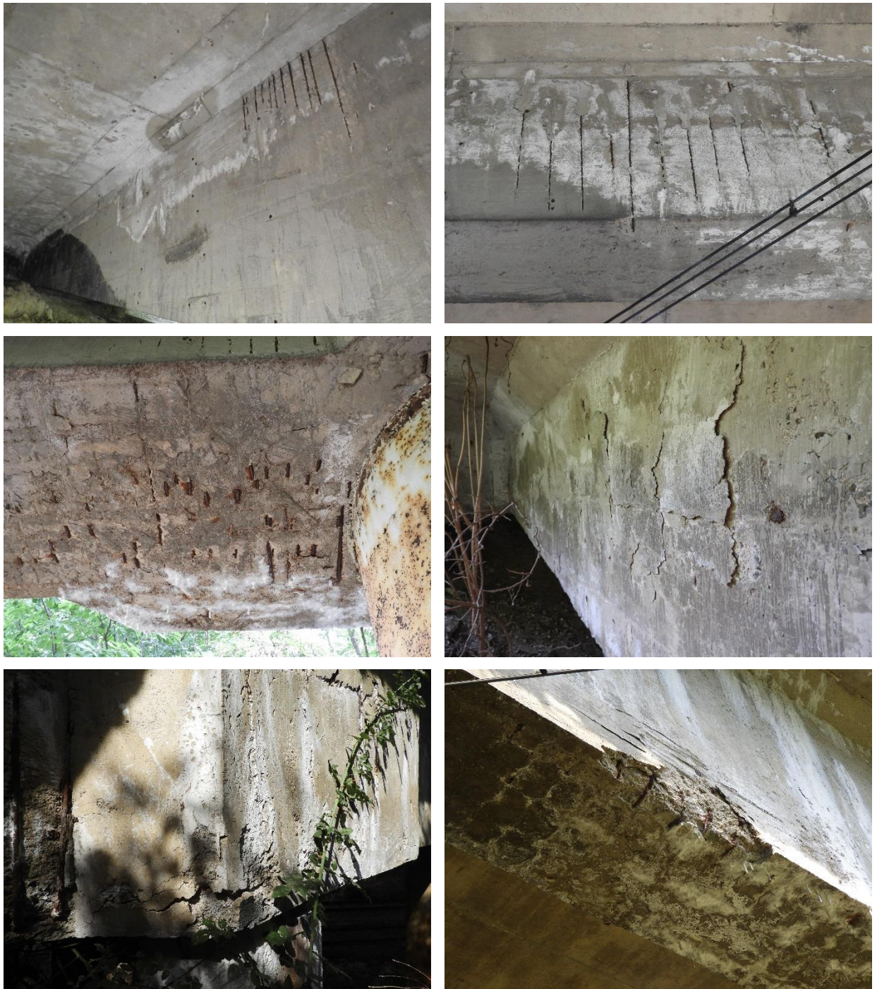
Fot. 3.32. Przykładowe fotografie przedstawiające stan techniczny konstrukcji dźwigarów głównych i poprzecznic
