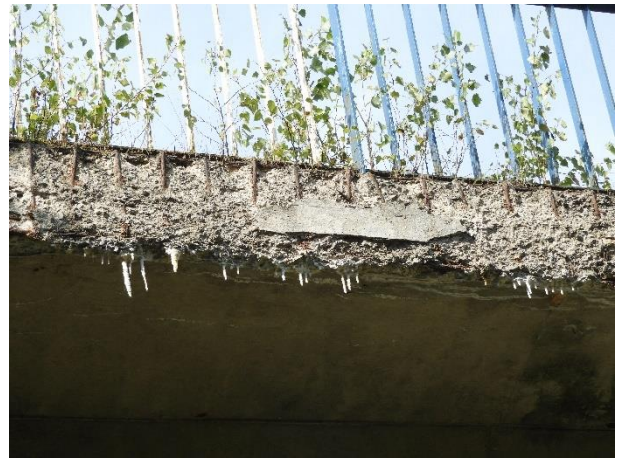
Fot. 3.19. Przykładowe fotografie przedstawiające stan techniczny belek podporęczowych, gzymsów
