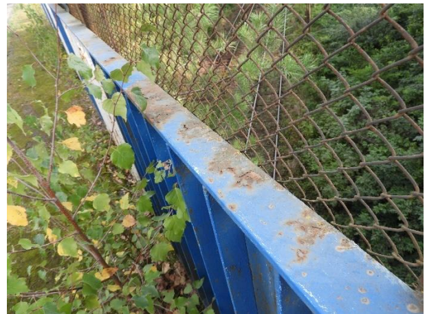
Fot. 3.12. Przykładowe fotografie przedstawiające stan techniczny balustrad, osłon przeciwporażeniowych
