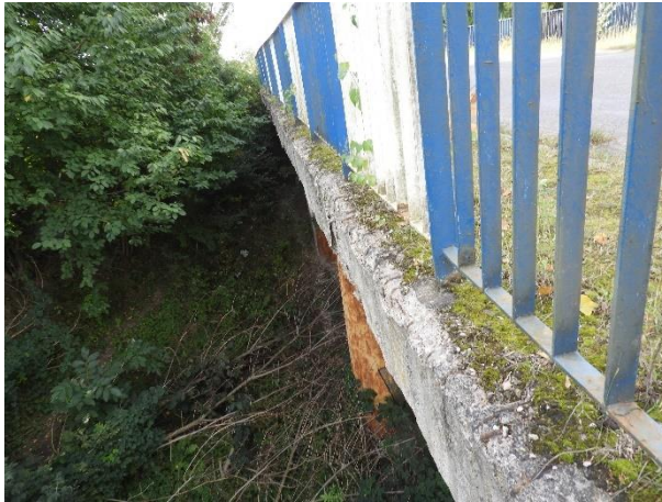
Fot. 3.16. Przykładowe fotografie przedstawiające stan techniczny belek podporęczowych, gzymsów
