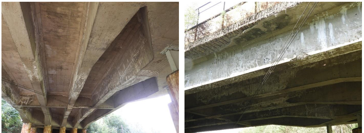
Fot. 3.29. Przykładowe fotografie przedstawiające stan techniczny konstrukcji dźwigarów głównych i poprzecznic
