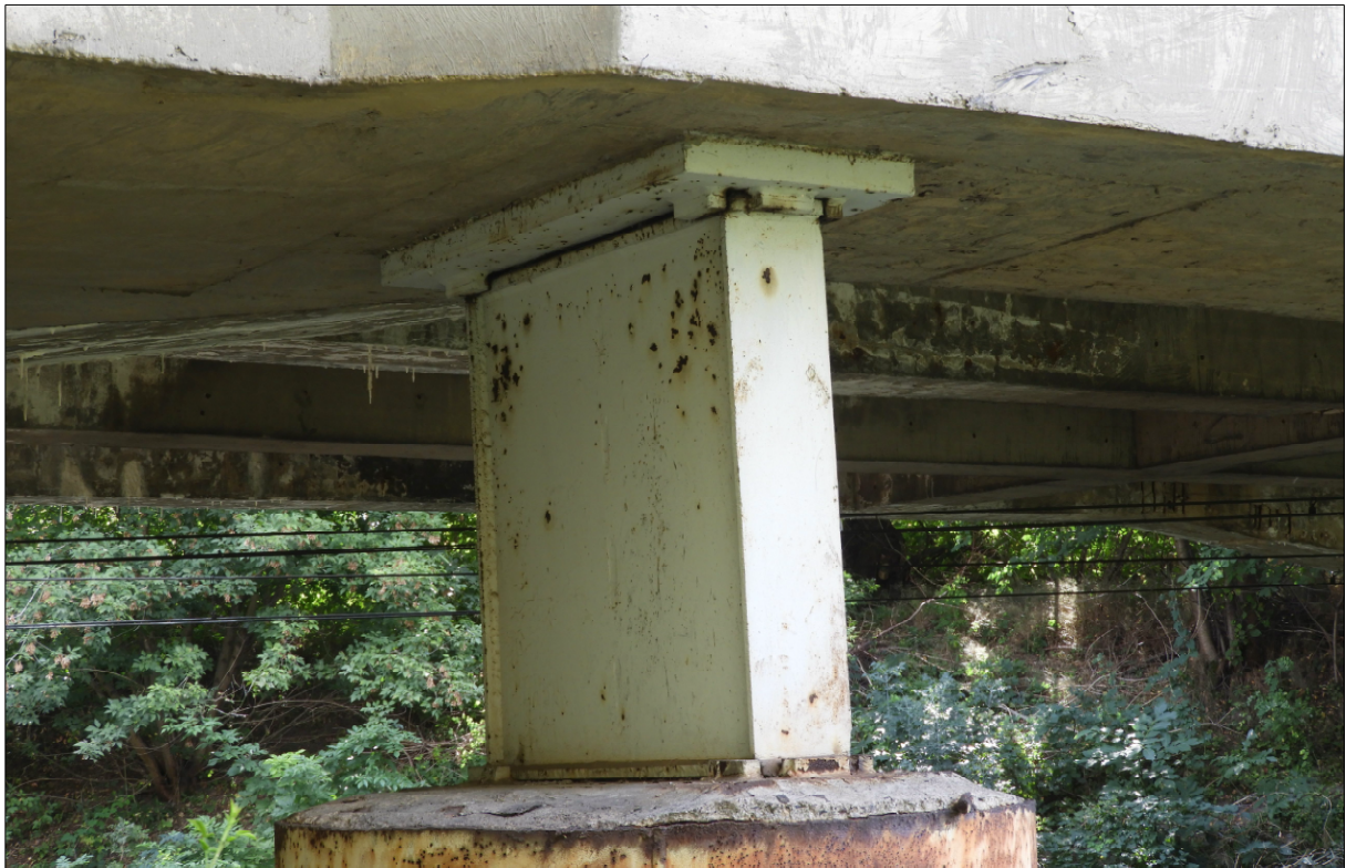
Rysunek 1.3-7: Widok łożyska typu wahacz
