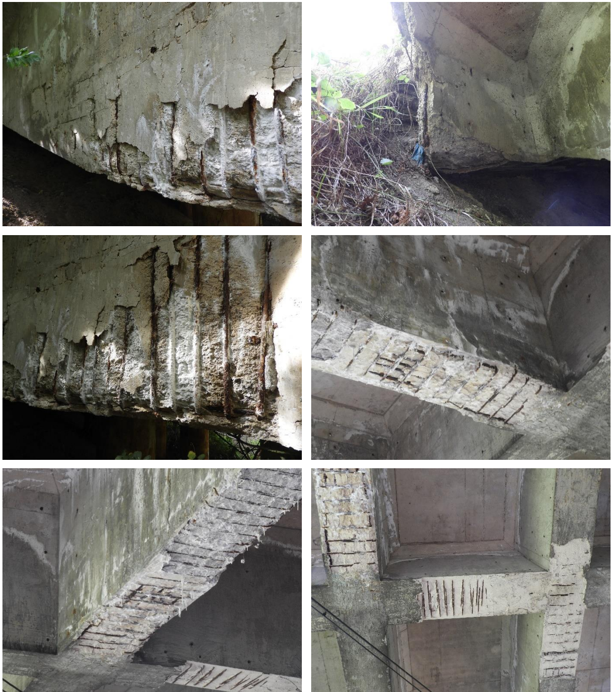
Fot. 3.34. Przykładowe fotografie przedstawiające stan techniczny konstrukcji dźwigarów głównych i poprzecznic
