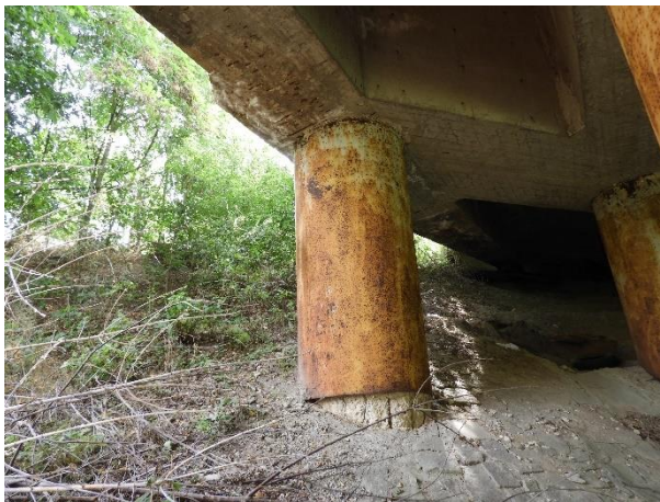
Fot. 3.40. Przykładowe fotografie przedstawiające stan techniczny filarów
