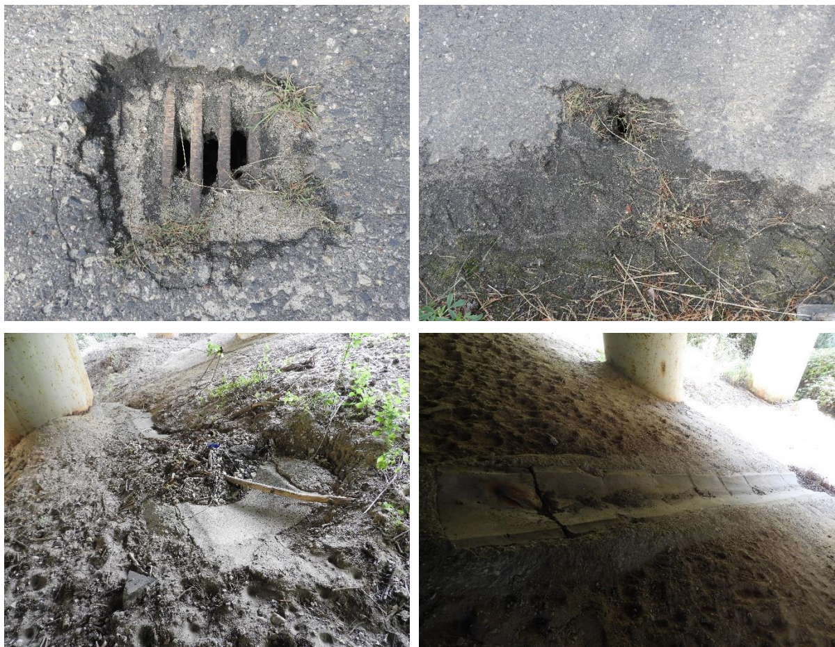
Fot. 3.21. Przykładowe fotografie przedstawiające stan techniczny urządzeń odwadniających
