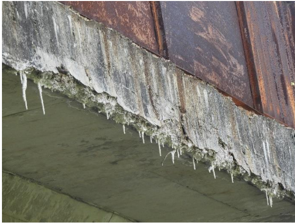
Fot. 3.16. Przykładowe fotografie przedstawiające stan techniczny belek podporęczowych, gzymsów
