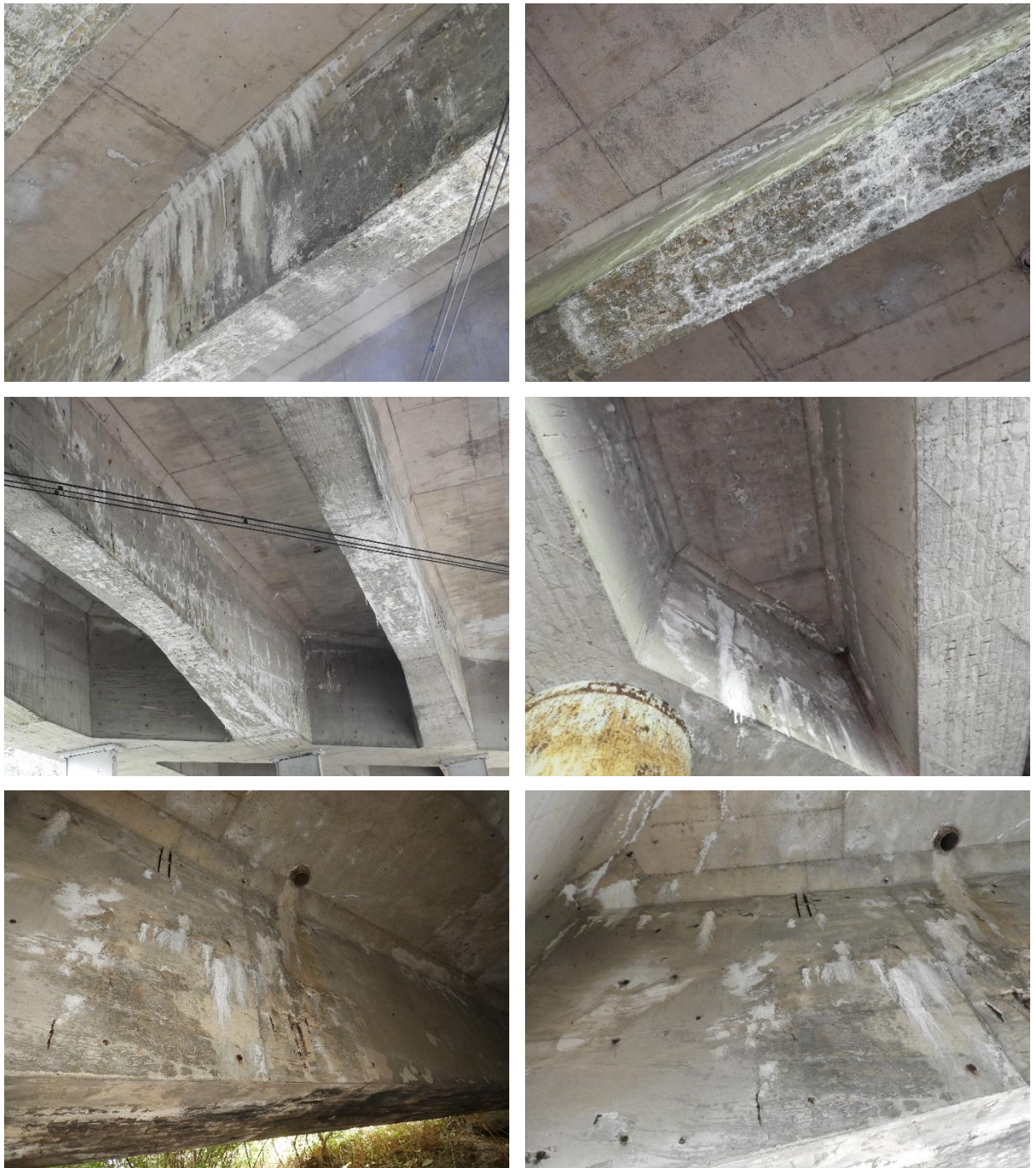
Fot. 3.31. Przykładowe fotografie przedstawiające stan techniczny konstrukcji dźwigarów głównych i poprzecznic
