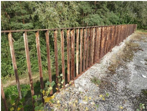
Fot. 3.13. Przykładowe fotografie przedstawiające stan techniczny balustrad, osłon przeciwporażeńowych
