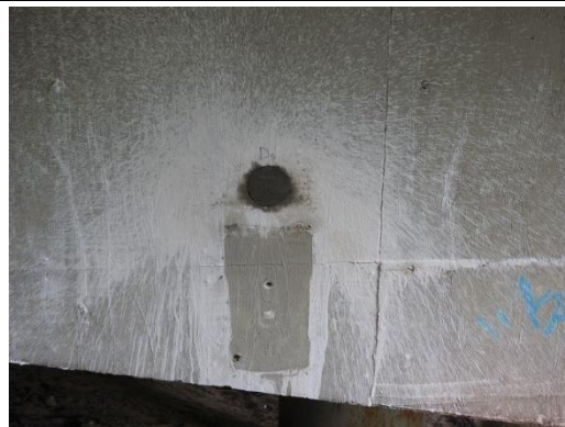
Fot. 4.3 Przykładowe fotografie przedstawiające przebieg prowadzonych odwiertów.
