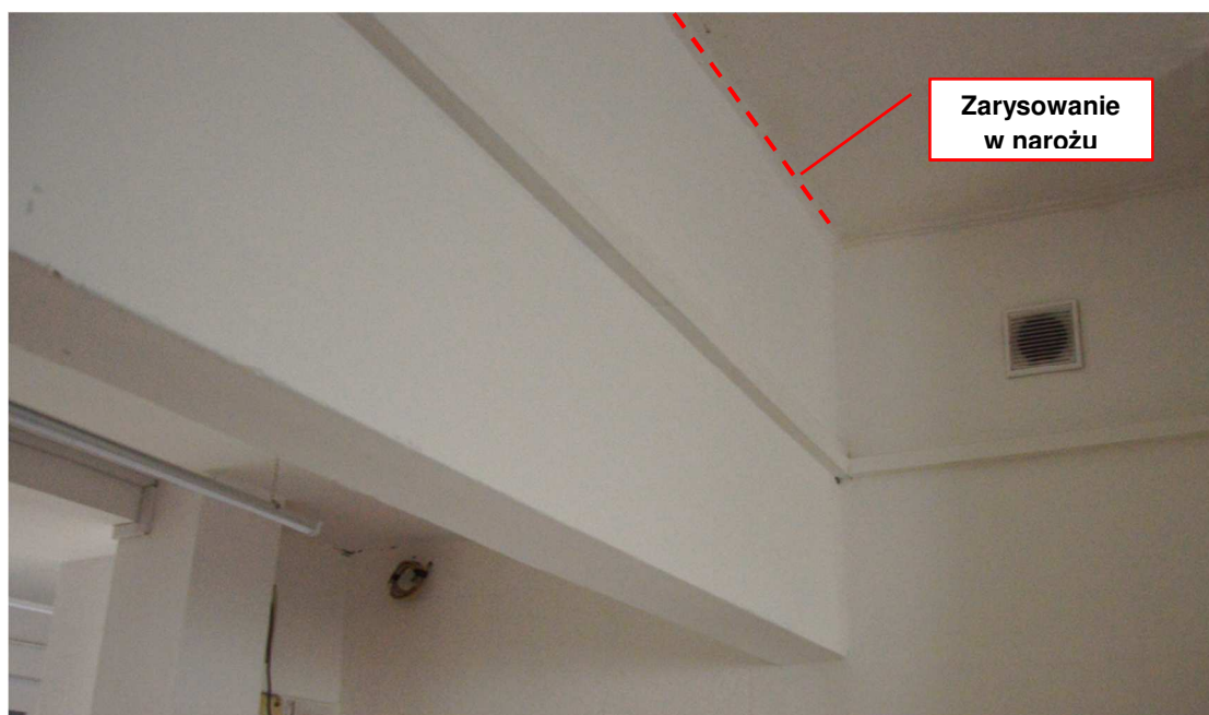
Fot. 3. Widok ogólny fragmentu pozostawionej ścianki pod stropem, oznaczenie miejsca zarysowania w narożu ścianka-strop świadczącego o deformacji ścianki [1.2].
