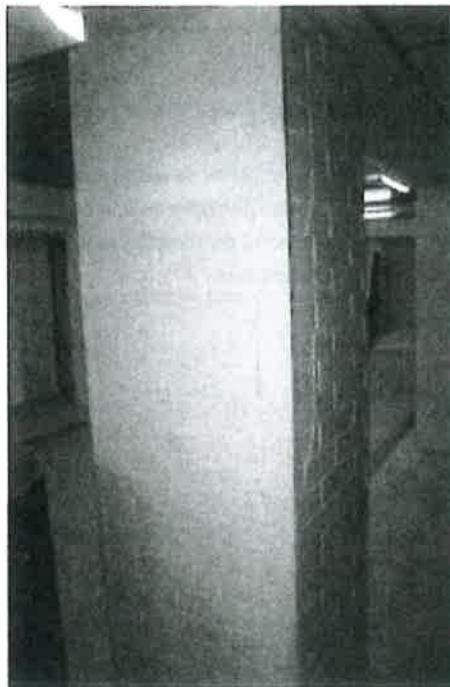
Fot. 2. Zarysowania i spekania podłużnie widoczne na okładzinach słupów
