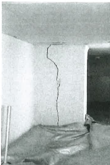
Fot. 4. Spekanie podłużne słupa w pompowni p.poz – widok od strony pomieszczenia.
