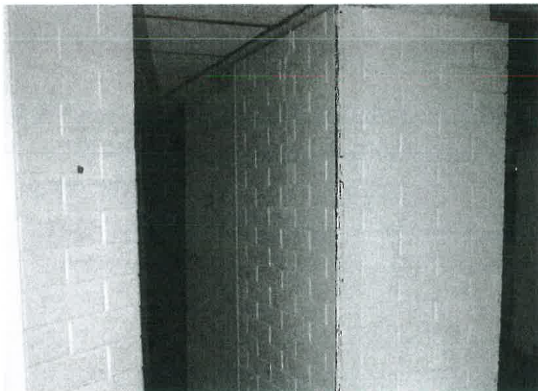
Fot. 8. Poszerzony słup w korytarzu głównym podziemia Hali Piaskowej. Zaznaczono przebieg zarysowania ściany bocznej.
