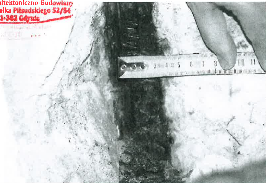
Fot. 7. Stan zaawansowane; korozji kątownika stalowego istniejącego słupa, stanowiącego wzmocnienie jego naroża.
