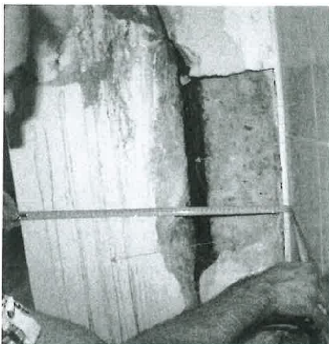
Fot. 6. Odkrywką nr 2 – słup w pompowni p. poz.
