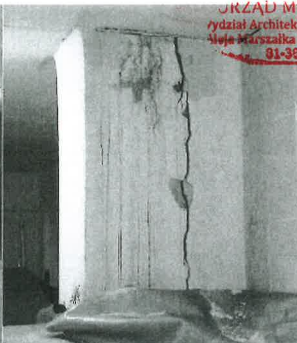
Fot. 5. Spekanie podłużne słupa w pompowni p.poz – widok od strony korytarza (drzwi zewnętrzne)
