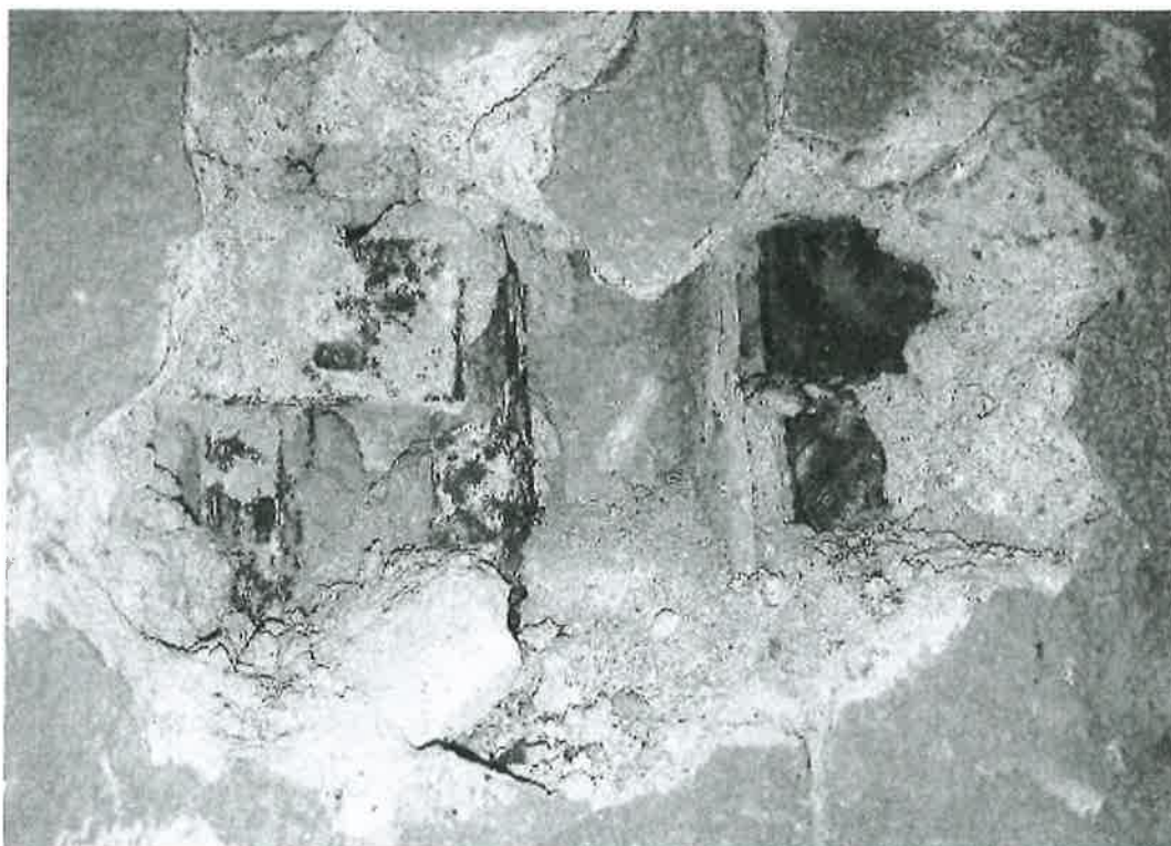
Fot. 10. Odkrywka nr 3 poszerzonego słupa. Widoczne pręty zbrojeniowe i płaskowniki obejmujące żelbeton oraz przekładka dylatacyjna z płyty pilśniowej zastosowana na styku dwóch elementów żelbetonowych
