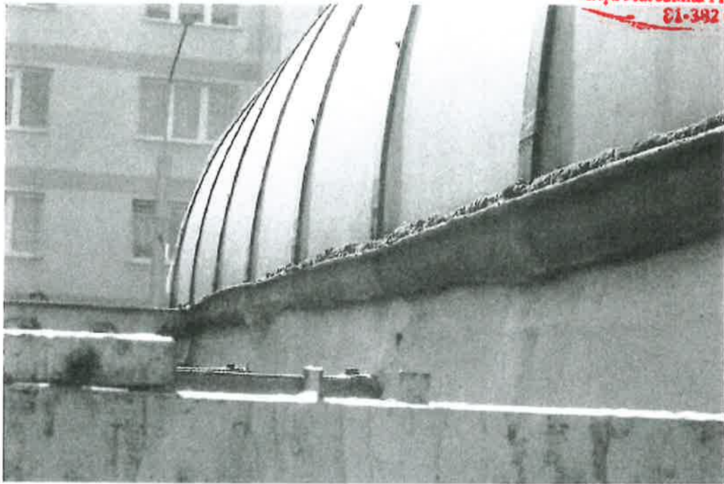
Fot. 3 Uszkodzenia izolacji przeciwwodnej w okapie zadaszera lukowego
