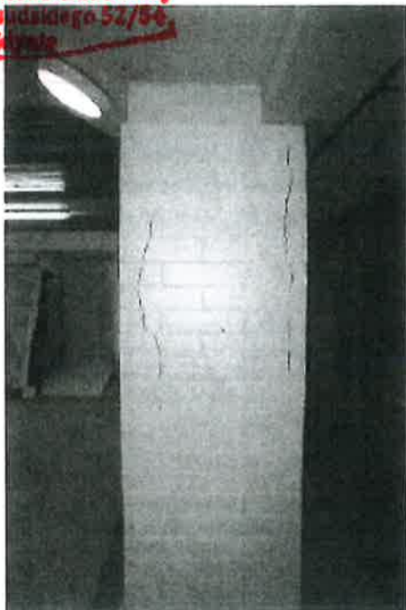
Fot. 1. Zarysowania i spekania podłużnie widoczne na okładzinach słupów
