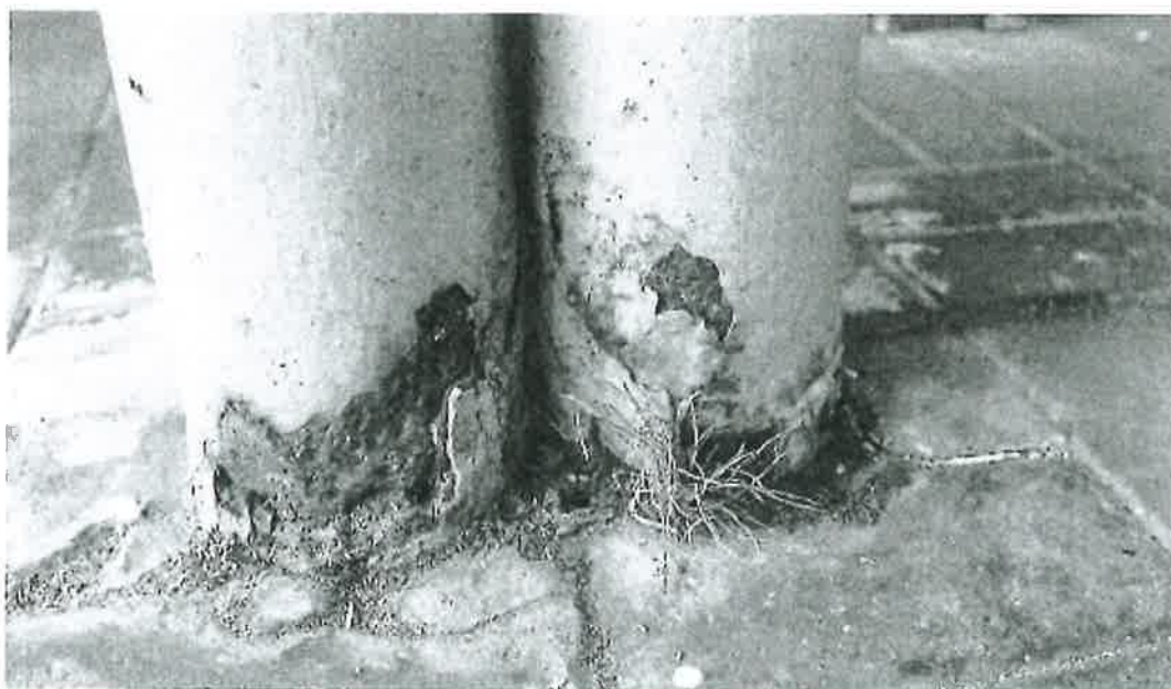
Fot. 8. Stan zachowania słupa nr 108 luz nad kosłką betonową
