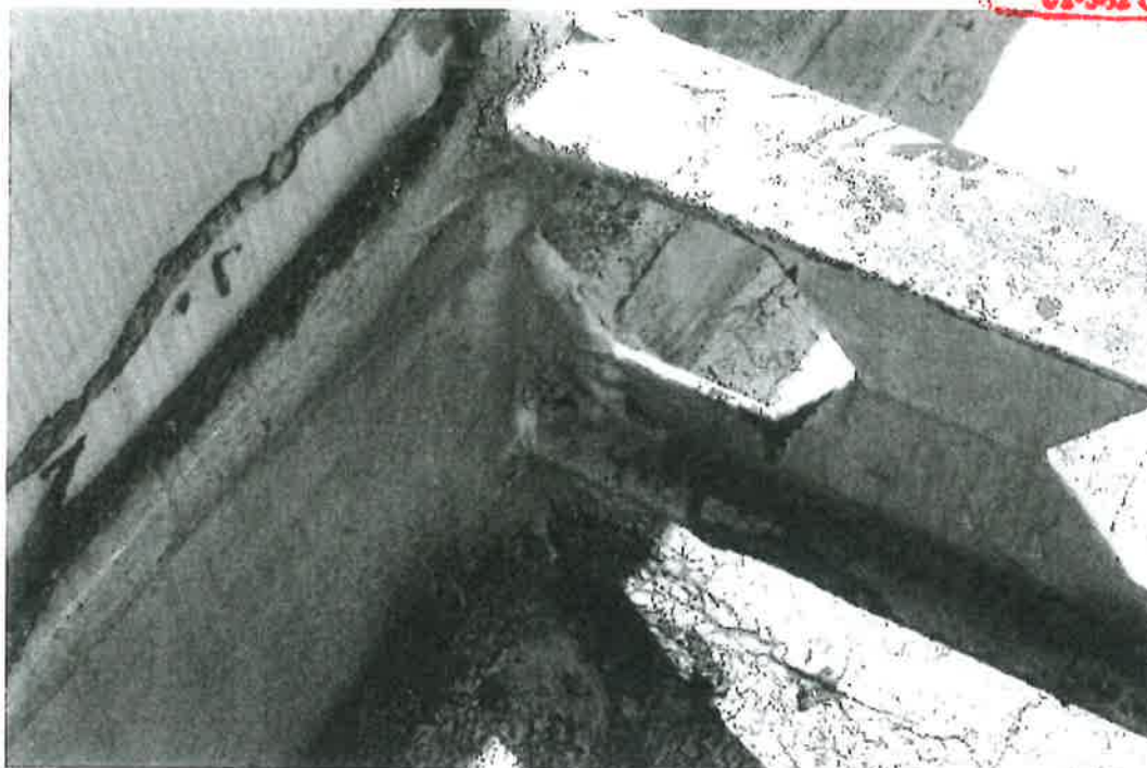
Fot. 7 Rygiel poprzeczny- sposób wykonania izolacji przeciwwodnej
